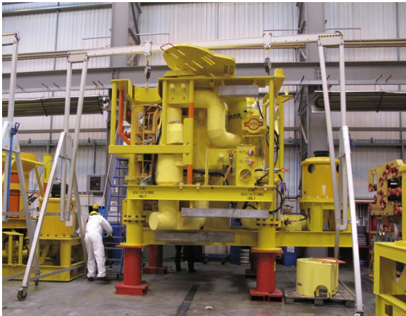
Elevación de maquinaria industrial
