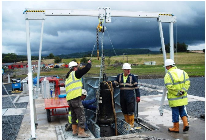
Elevación de instalaciones
