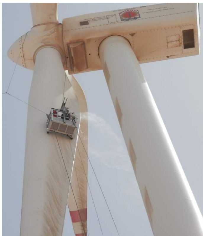
GAMESA G8X, mantenimiento de palas (limpieza)
