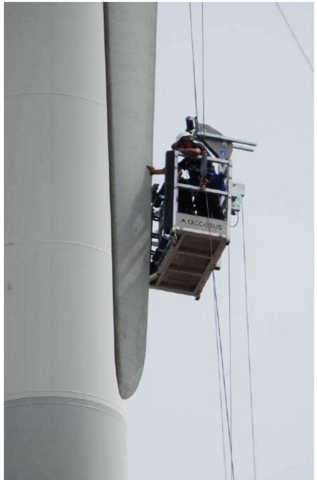
GAMESA G8X, mantenimiento de palas (punta)
