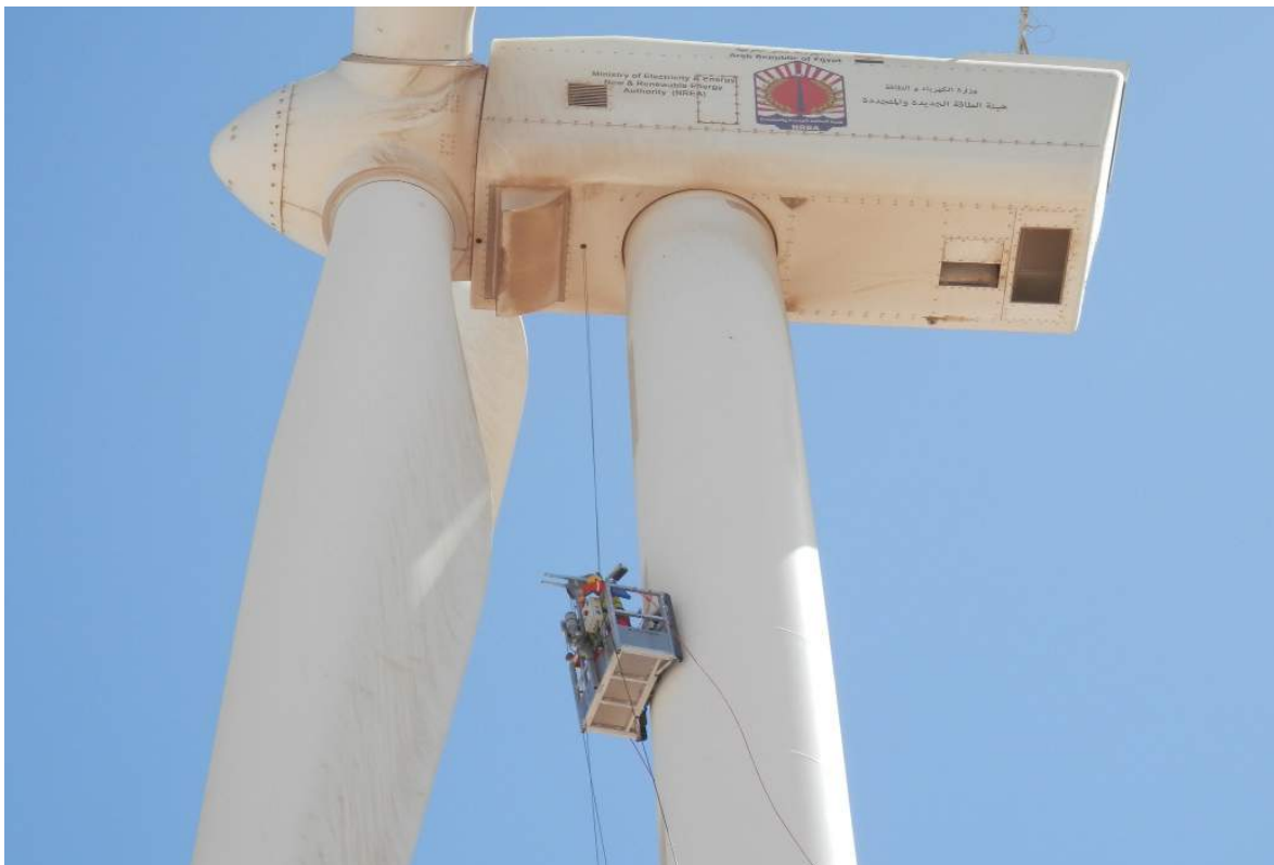
GAMESA G8X, mantenimiento de torre (limpieza)
