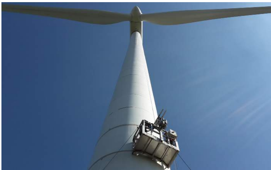
VESTAS V90, mantenimiento de torre (reparación de juntas)
