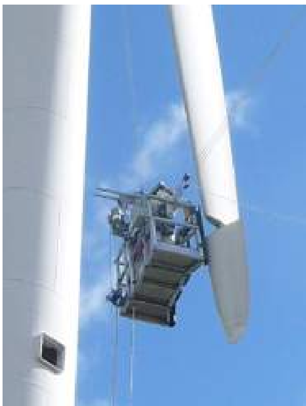
MADE, mantenimiento de palas (punta)
