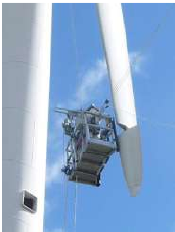
MADE, entretien de la lame (pointe)
