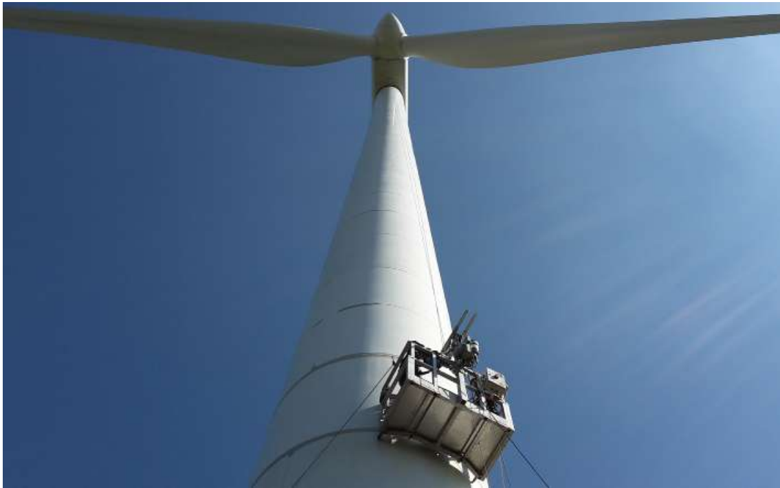
VESTAS V90, maintenance de la tour (réparation conjointe)
