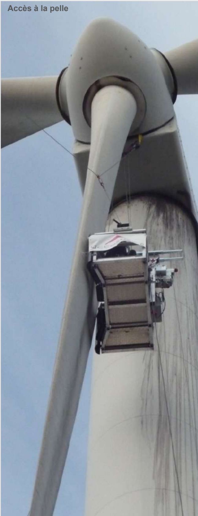
Accès à la tour
