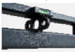
6 points d'ancrage fixes sur la poutre
