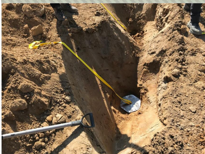
Aplicação prática do ponto de ancoragem PAT 189 em obra.
