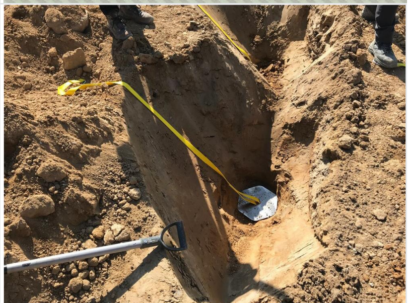
Application pratique du point d'ancrage PAT 189 sur le terrain.
